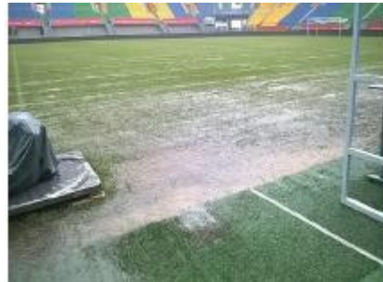
Результат сильної зливи на полі із поганою дренажною системою. Такий стан газону може призвести до перенесення матчу.
