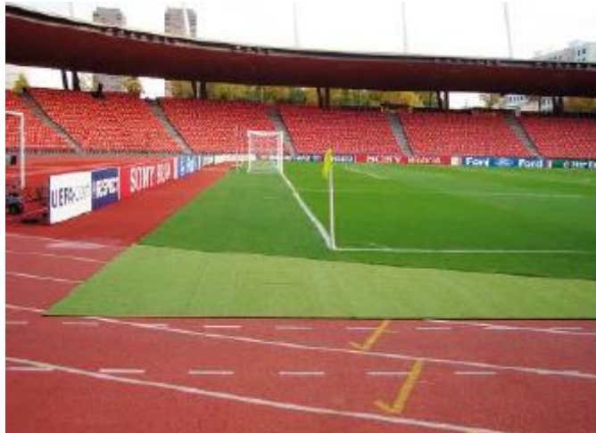
Мал. 27 Розширення периметру газону довкола поля, накривши ділянки високоякісною штучною травою.
