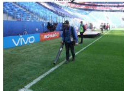
Мокра фарба – прискорити висихання розмітки піддуваючи повітродувкою для опалого листя.
