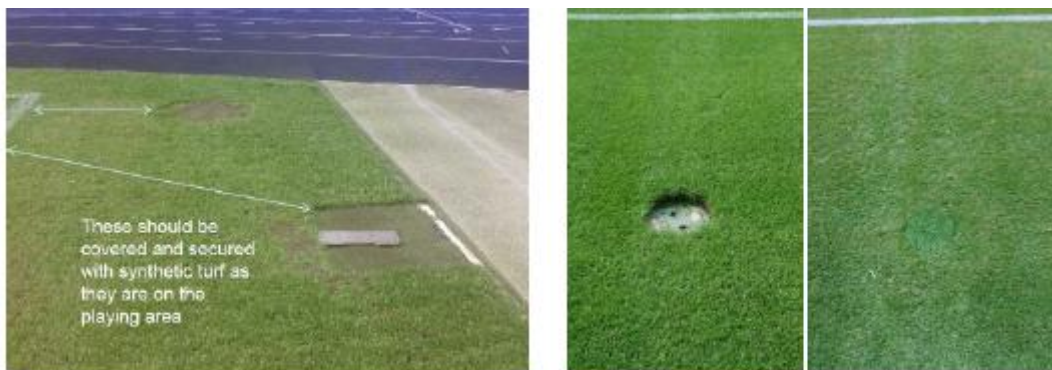
Мал. Такі деталі накрити синтетичною травою та надійно зафіксувати, оскільки вони знаходяться на полі для гри.
