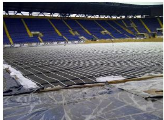
Мал. 6 Теплові підґрунтові труби кладуть рейками поверх дренажного прошарку із гравійною засипкою до закладання кореневої зони.
